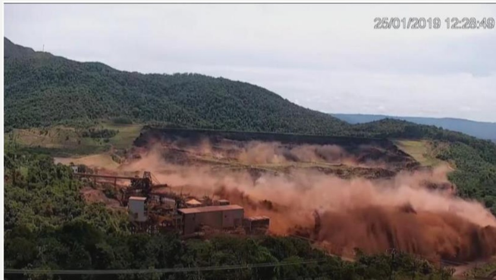
Imagem mostra momento exato do rompimento da barragem da Vale em Brumadinho (MG)
